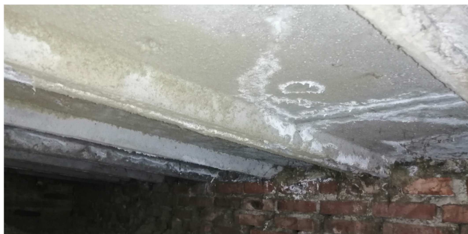
Fot.1 Widok ogólny na płyty korytkowe (widoczne ślady po nieszczelności poszycia)
